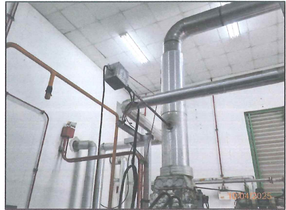
ปล่องหม้อไอน้ำ (Boiler Stack)
